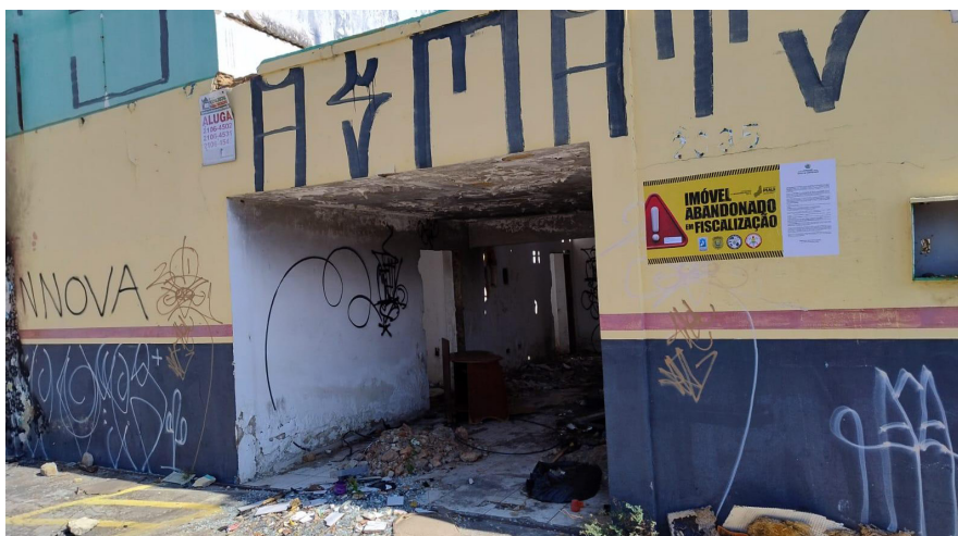
Figura 1 - Imóvel abandonado no centro de Teresina.
